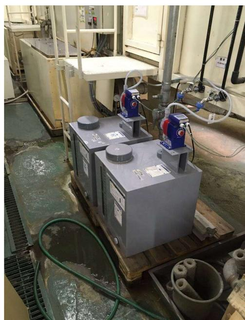
被膜薬品補給装置
